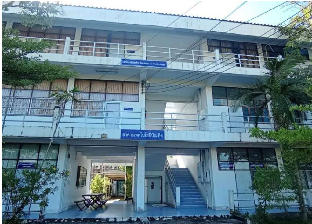
อาคารเรียน 3 ชั้น เทคโนโลยีบัณฑิต
