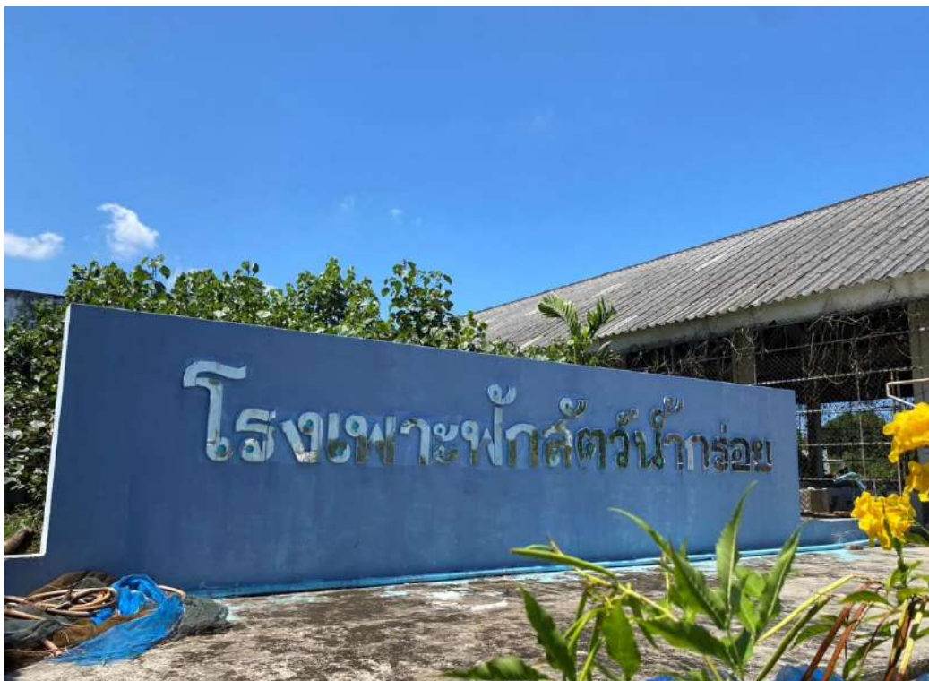
อาคารโรงเพาะฟักสัตว์น้ำกร่อย
